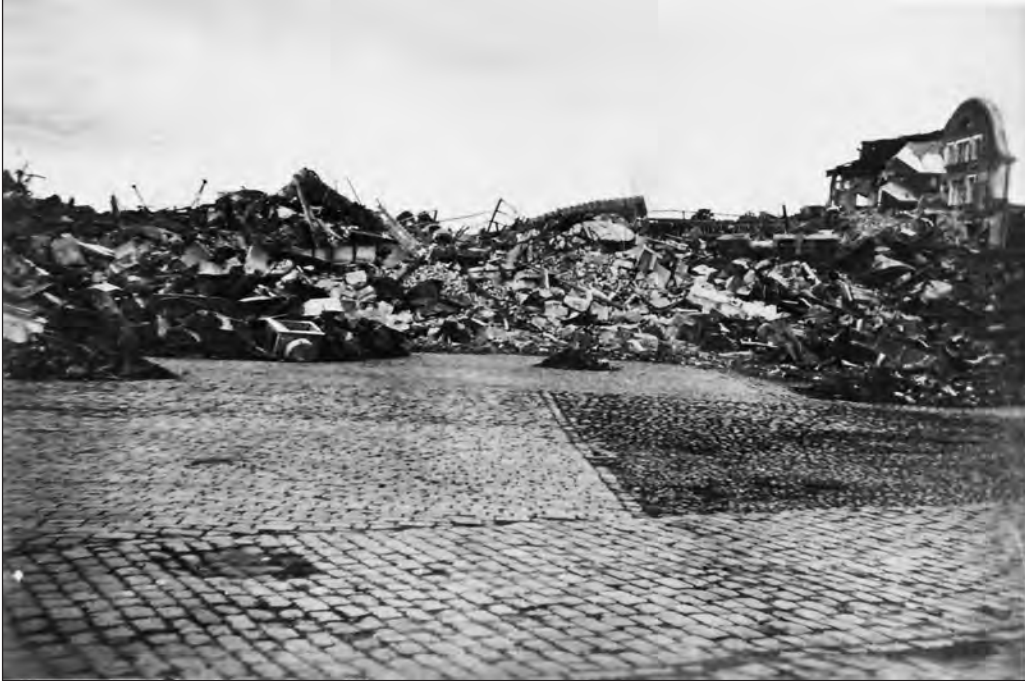
Viipuri vallattiin takaisin 28.8.1941. Viipurin asemarakennus oli näin pahoin tuhoutunut.
