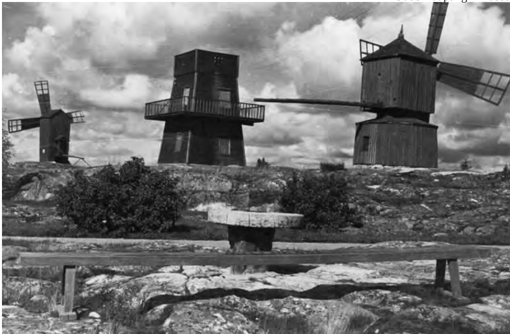
Keskellä Myllymäen ilmaavastustorni. Sotilaspojat toimivat sen ja suojeluskuntatoimiston välillä lähetteinä. Torni oli käytössä vv. 1941 – 1944.
