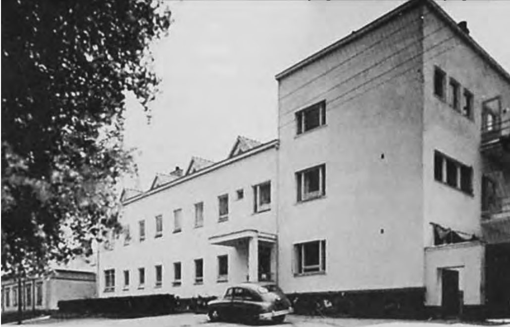
Uudenkaupungin seudun sairaala valmistui 1936. Tammikuussa 1940 se muuttui sotasairaalaksi. Vasemmalla näkyy silloinen kulkutautisairaalan rakennus, joka sekin toimi sotasairaala.
