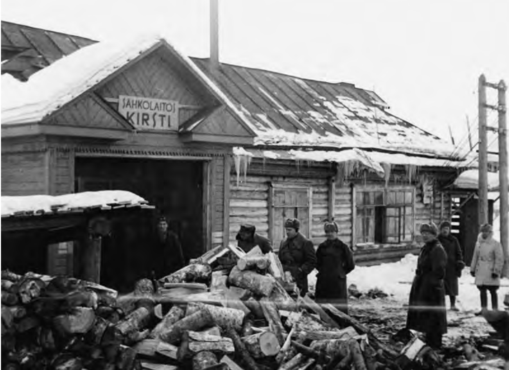
Sähkölaitos Kirsti. Tyttöjen nimillä varustettuja lokomopiisähkölaitoksia oli Aunuksessa useita. Lokomopiili oli siirrettävä höyrykattila ja höyrykone, jossa oli sähkögeneraattori. Polttoaineena käytettiin halkoja. Kuvassa etualalla oikealla sähköosaston päällikkö kapt. ins. E.O. Aittakallio.
