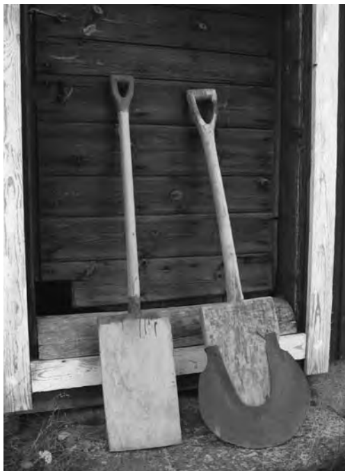
Maaseudulle sijoitetut sotavangit osoitettiin aluksi lähinnä ojanperkaustyöhön. Tällaisilla työvälineillä kaivettiin ojat siihen aikaan.
